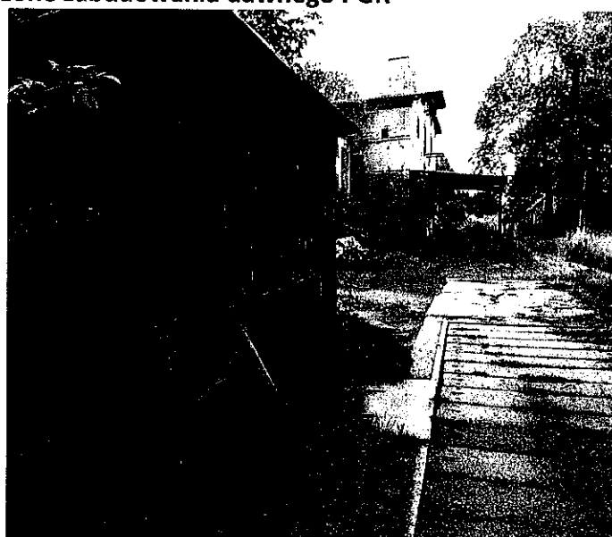
Rysunek 18. Zniszczone zabudowania dawnego PGR
