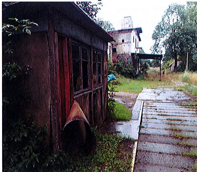
Rysunek 18. Zniszczone zabudowania dawnego PGR
