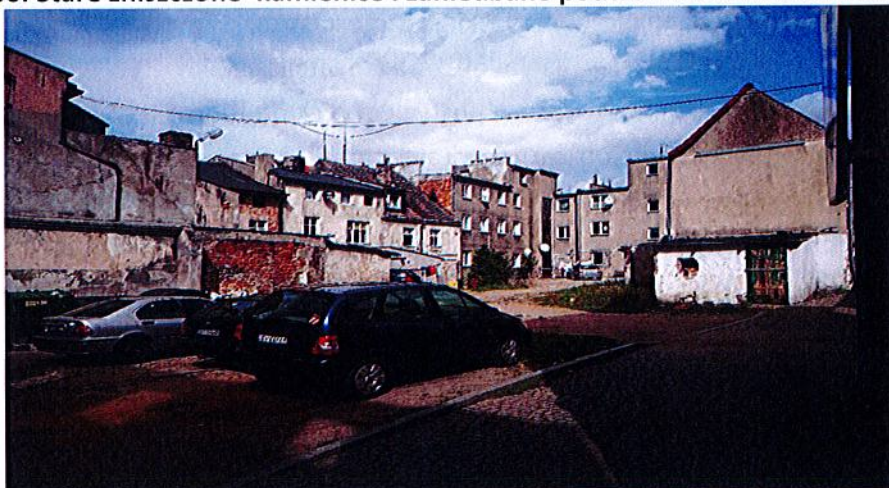
Rysunek 60. Stare zniszczone kamienice i zaniedbane podwórka w obszarze rewitalizacji
