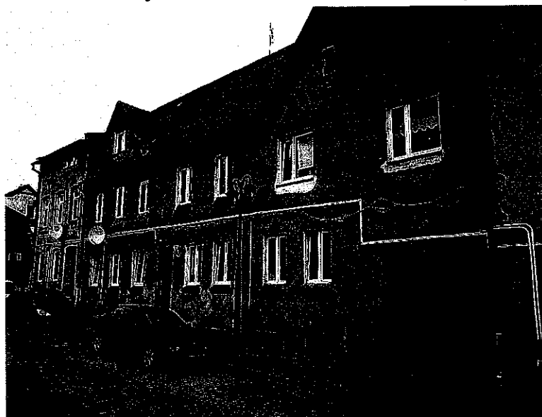
Rysunek 58. Zniszczone elewacje kamienic w obszarze rewitalizacji
