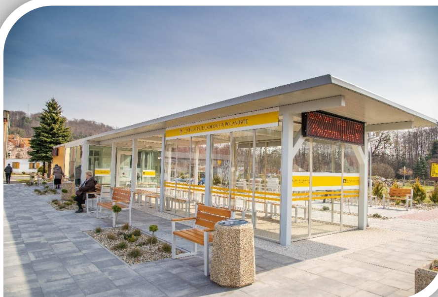
Fotografia 9. Centrum przesiadkowe w Polanowie
